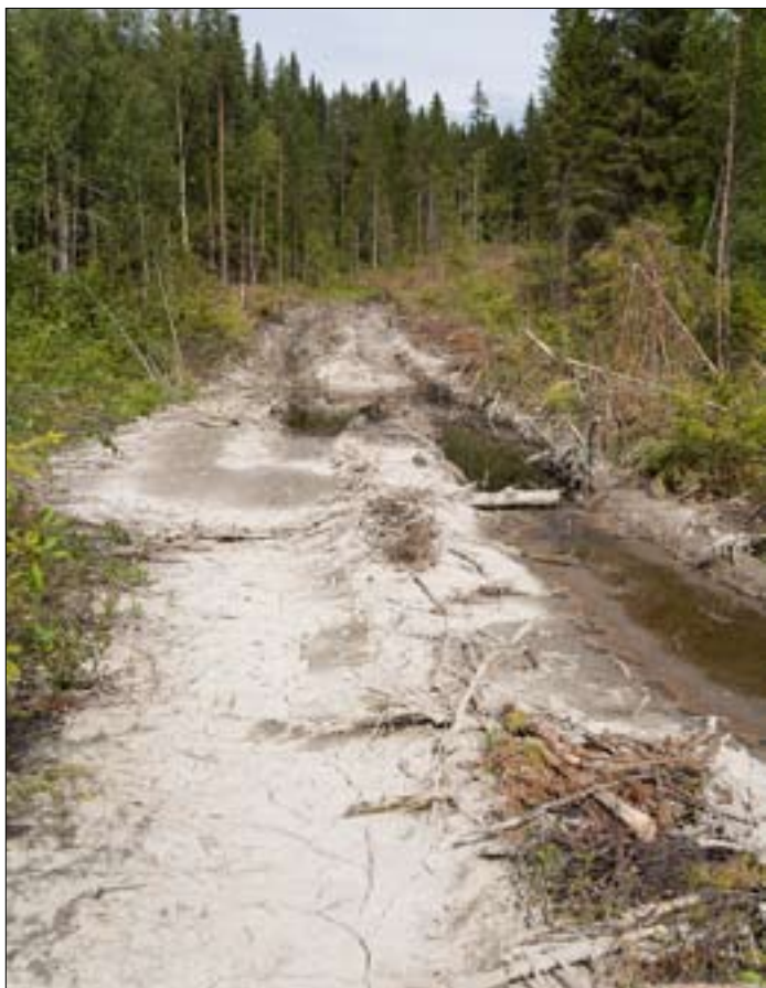
Före och efter grävaren har gjort sitt jobb. Surhållet är borta och vägbanan är klar så när som på bärlagret.
