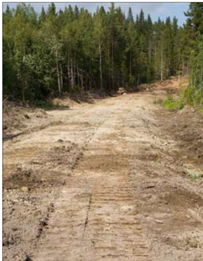
Före och efter grävaren har gjort sitt jobb. Surhållet är borta och vägbanan är klar så när som på bärlagret.
